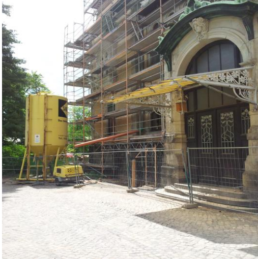
Das ehemalige Bethanien-Krankenhaus wird zum Ambulanten Reha-Zentrum umgebaut. Foto: St. Elisabeth-Krankenhaus Leipzig
